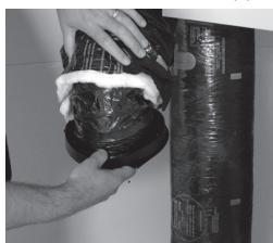
Insérer le conduit en vinyl par-dessus les quatres agrafes de fixation et serrer avec un collet de serrage (30 po).
