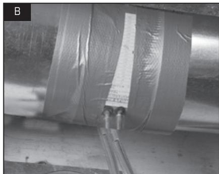
**1** Pour ce poste de mesure des débits, coupez le conduit et placez le poste entre chaque section de conduit. Assurez-vous que la flèche de sens de l'air du poste de mesure des débits pointe dans le sens du débit d'air. Fixez le poste de mesure des débits avec du ruban adhésif.
