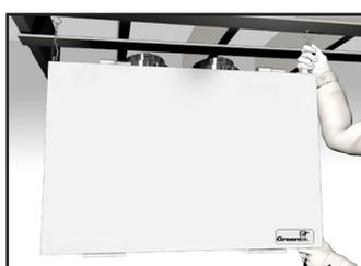
**3** Suspendez le VRC en faisant glisser un maillon de la chaîne dans les crochets de suspension et assurez vous que l'appareil est de niveau.
