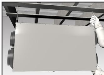
**3** Suspendez le VRC/VRE en faisant glisser un maillon de la chaîne dans les crochets de suspension et assurez vous que l'appareil est de niveau.
