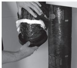
Insérer le conduit en vinyle par-dessus les quatre agrafes de fixation et serrer avec un collet de serrage (30 po).
