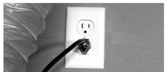
figure 10.2 Cordon électrique du VRC/VRE. Votre système est muni d'un fil de raccord pour une prise de 120 volts. Il est déconseillé d'utiliser un rallonge électrique pour connecter votre système. Si vous n'avez pas accès à une prise de courant avec un circuit distinct, il est recommandé de faire appel à un électricien pour en faire l'installation.
