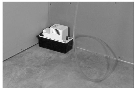
figure 9.2 Ensuite, raccorder au renvoi ou à la pompe de condensation si vous n'avez pas accès au drain du plancher.
