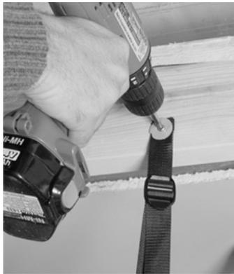
figure 6.1 Fixer les oeillets des courroies aux solives à l'aide de vis (#10 x 1)
