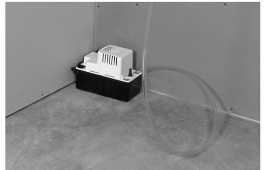
figure 8.2 Ensuite, raccorder au renvoi ou à la pompe de condensation si vous n'avez pas accès au drain du plancher.
