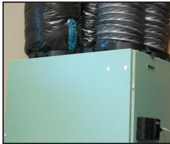
Step 1: Insérer le conduit en vinyl par-dessus les quatre agrafes de fixation.
