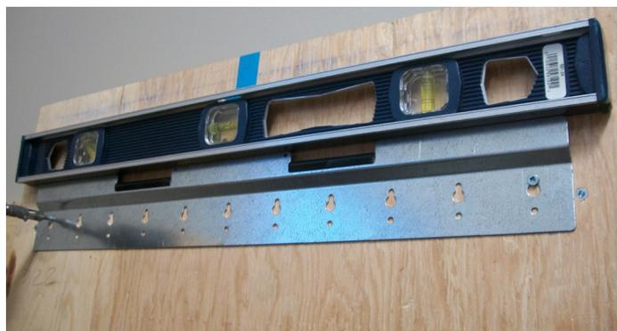
figure 6.1 Installation du support mural. Sécuriser avec deux écrous de #10 x 1-1/4 po.
