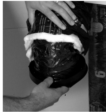
figure 7.1 Insérer le conduit en vinyle par-dessus les quatre agrafes de fixation et serrer avec un collet de serrage (30 po).
