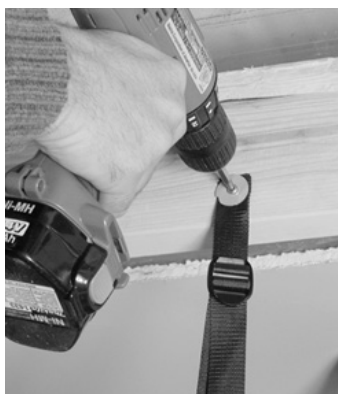
figure 5.2 Fixer les oeillets des courroies aux solives à l'aide de vis (#10 x 1)
