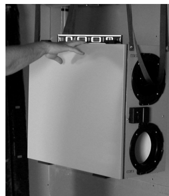
6.3 Terminer l'installation en vous assurant de bien niveler l'unité.
