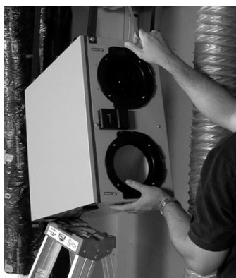
figure 6.2 En tirant sur la courroie et en soulevant l'unité, fixer à la hauteur désirée.
