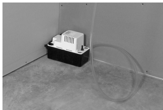
figure 8.2 Ensuite, raccorder au renvoi ou à la pompe de condensation si vous n'avez pas accès au drain du plancher.
