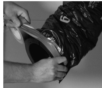
figure 7.3 Terminer par sceller le coupe vapeur au collet avec du ruban.
