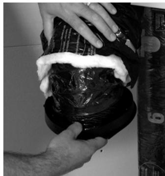
figure 7.1 Insérer le conduit en vinyl par-dessus les quatre agrafes de fixation et serrer avec un collet de serrage (30 po).
