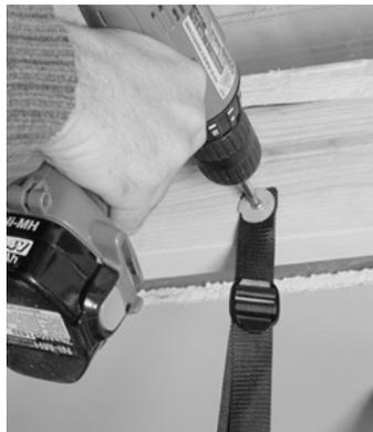
figure 5.2 Fixer les oeilletons des courroies aux solives à l'aide de vis (#10 x 1)
